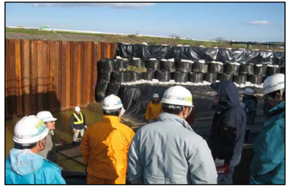
川表側鋼矢板及び大型土嚢による応急復旧状況
