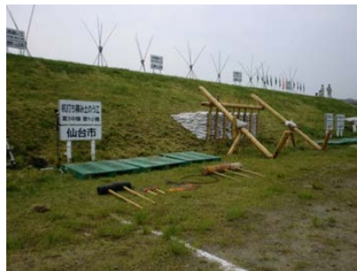
杭打ち積土のう工
