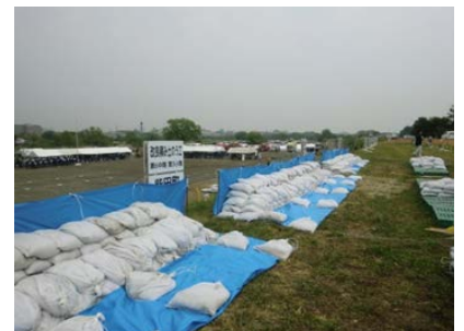
改良積み土のう工
