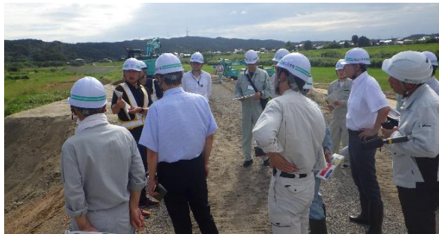
▲現地視察（越水による”ゆるみ”箇所の切返し状況）
