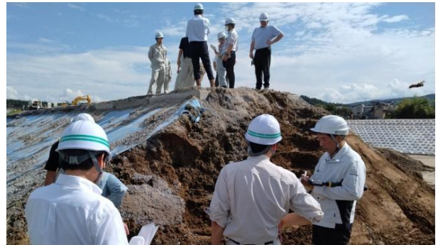
▲現地視察（堤防決壊箇所の開削部調査）
